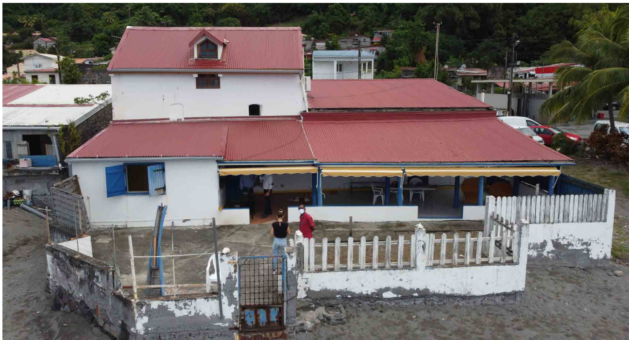
Façade Ouest avant rénovation
