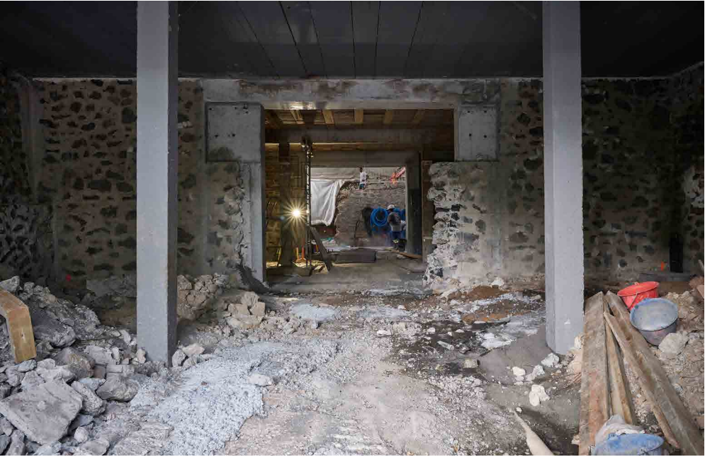
RDC en chantier : agrandissement des ouvertures
