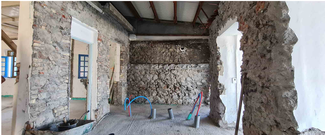
Mise à niveau les deux maisons
