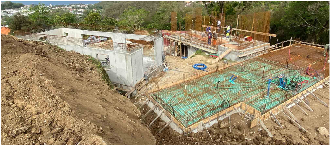
Gros-oeuvre en cours
