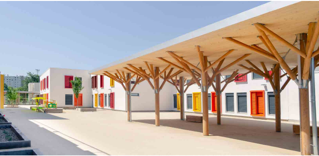
Photographie du bâtiment A
